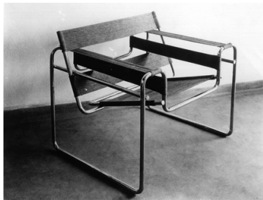
הכסא - כסא ווסילי, עוצב על ידי מרסל ברויאר סטודנט, ולימים מרצה בבאוהאוס. מראה מספר דברים - השימוש בצינורות מתכת מכופפים, טכניקה שפותחה על ידי ברויאר כשהיה סטודנט שימשה לסדרת כסאות מאד מוצלחת, ומראה את מסקנות הניתוח הפונקציונאלי של הכסא והישיבה. חומרים רכים ונמתחים במגע עם הגוף, ומה שלא צריך תמיכה, נשאר צף באוויר.
